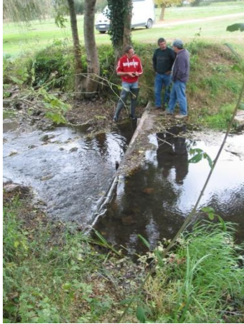
Seuil de mesures généré par la canalisation affouillée
