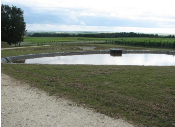
Bassin stockant les eaux de lavage des filtres
