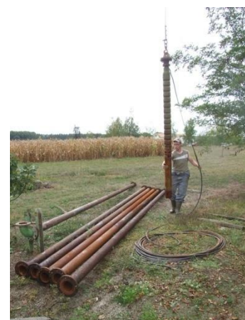
Dépose de pompe immergée
