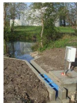
Pose d'un canal venturi
