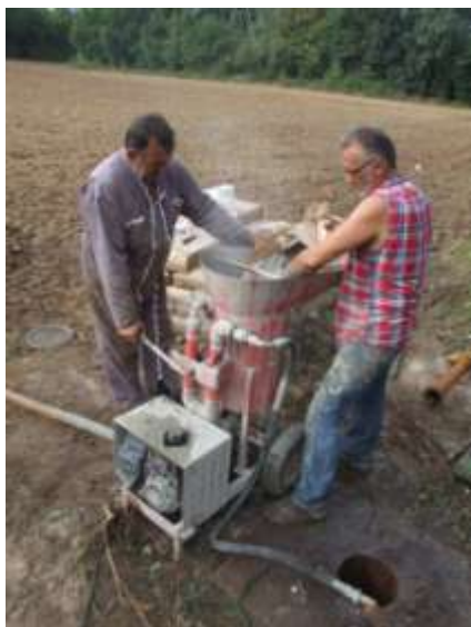
Cimentation de l'horizon imperméable
