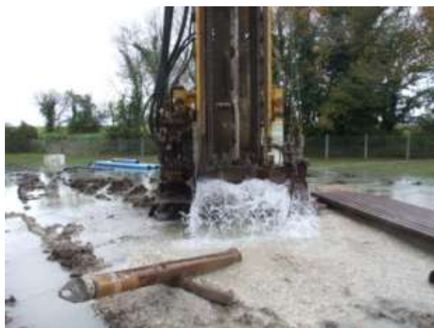
Captage de Poursay Garnaud "Bois de Vervant F 2 " : Soufflage du réservoir après tubage.
