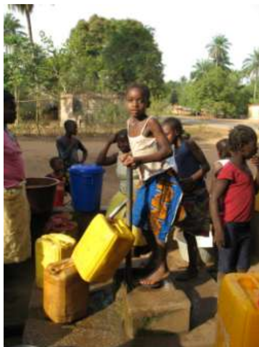
Forage équipé d'une pompe à motricité humaine réhabilité en 2012
