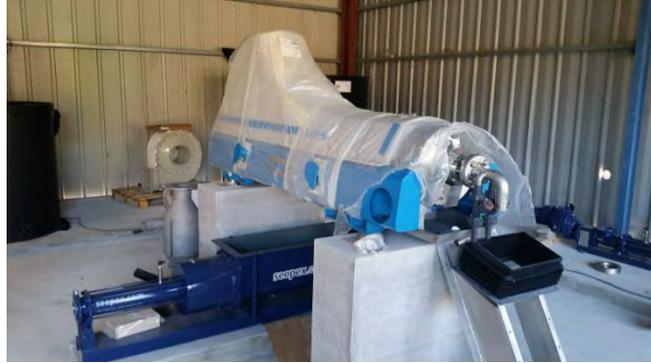
Ainsi, une filière complète de traitement des boues a été installée avec une centrifugeuse. En outre, des aménagements de la filière eau ont été réalisés en même temps permettant de fiabiliser et d'optimiser le fonctionnement de la station.
