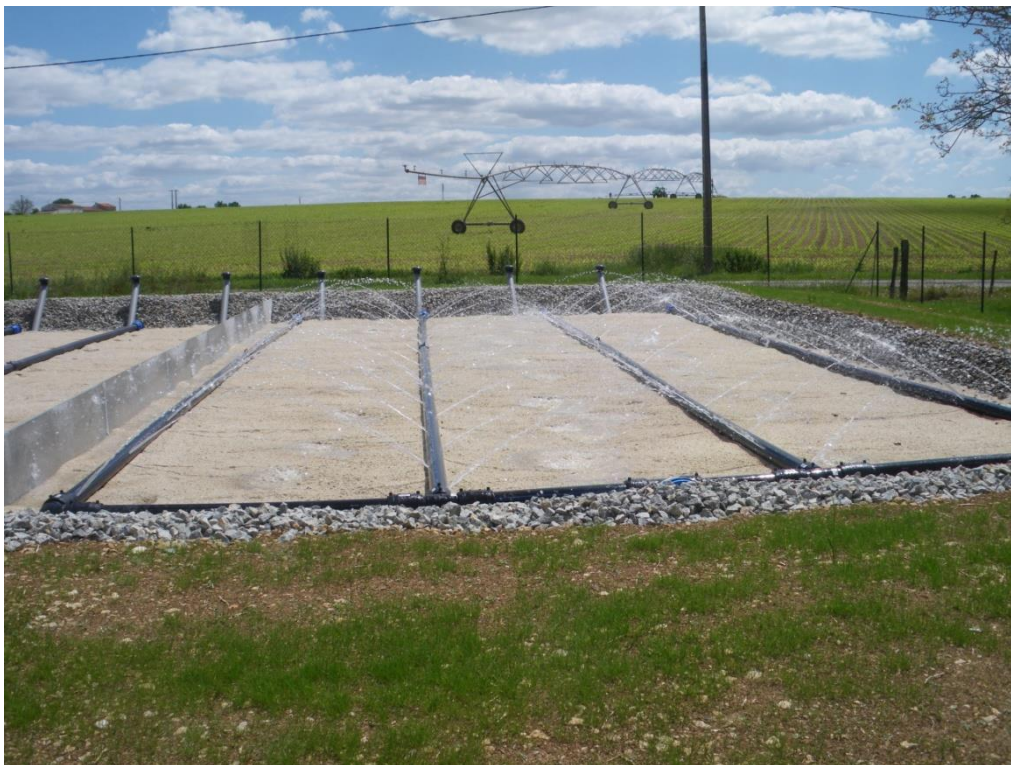
2 ème étage des lits plantés de roseaux de l'unité de traitement de Brettes (Saint Germain de Marencennes)
