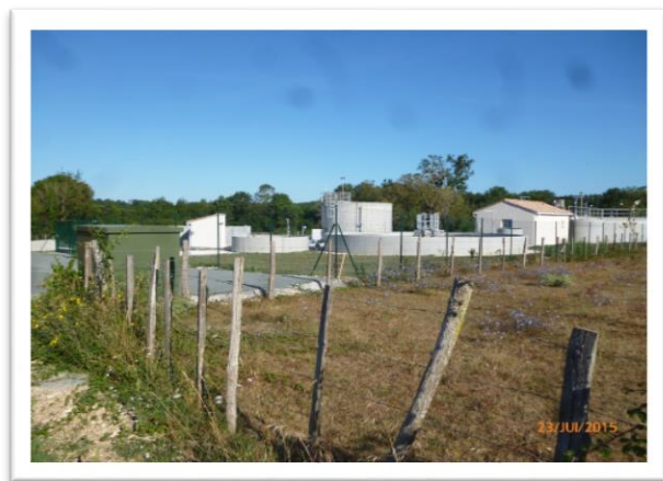
Station d'épuration de Bussac sur Charente
