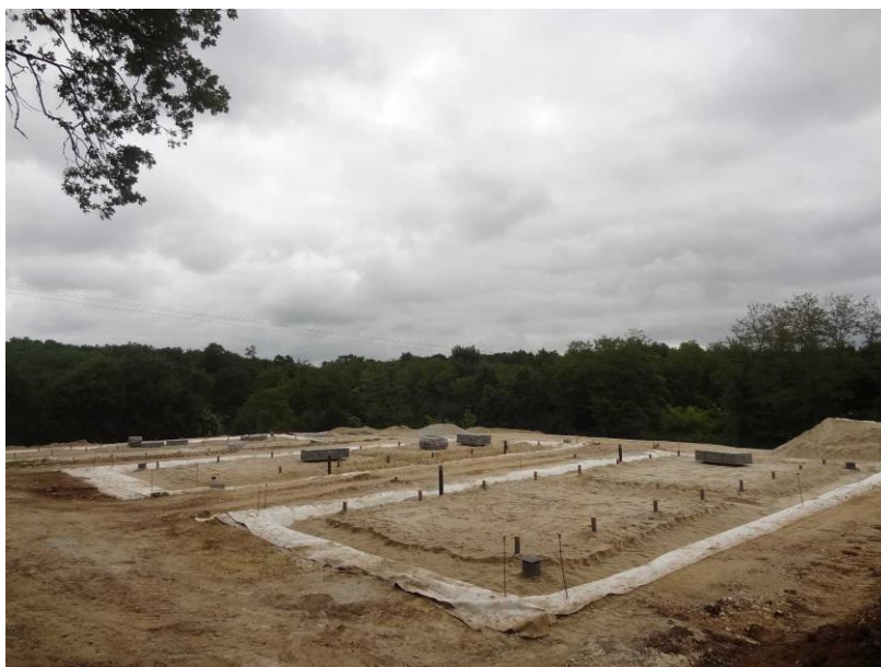
Les Essards : filtres plantés de roseaux en cours d'aménagement
