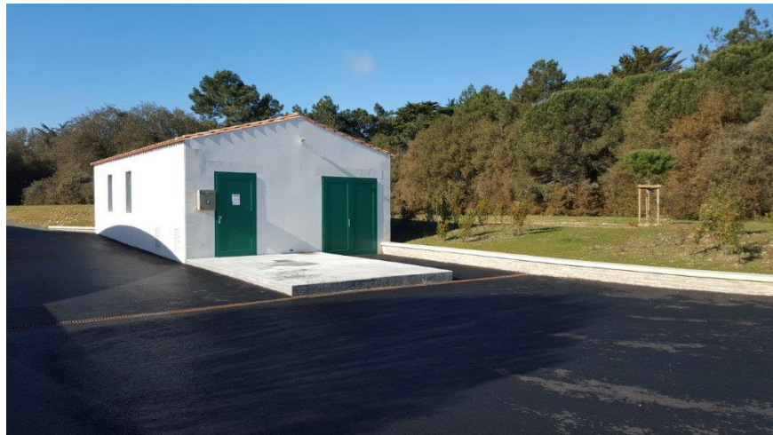
Unité de Traitement des Matières de Vidange à LAFLOTTE EN RE
