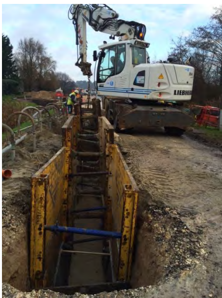
Difficultés d'un chantier à forte profondeur dans le sable et en présence de nappe
