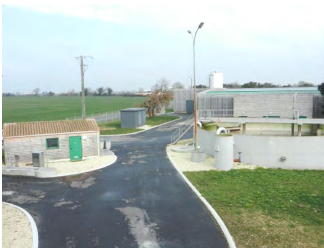
Doublement de la station d'épuration de Soubise
