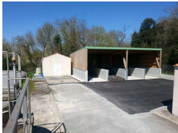
Modernisation du traitement des boues de la station d'épuration de Trizay
