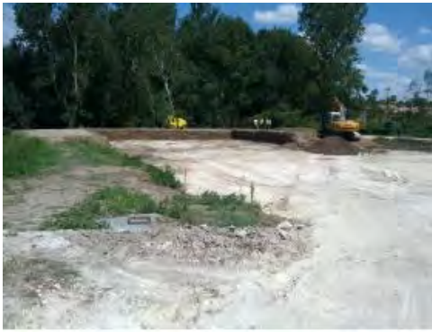
Terrassement de la première lagune
