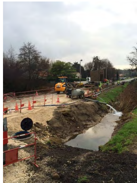
Difficultés d'un chantier à forte profondeur dans le sable et en présence de nappe
