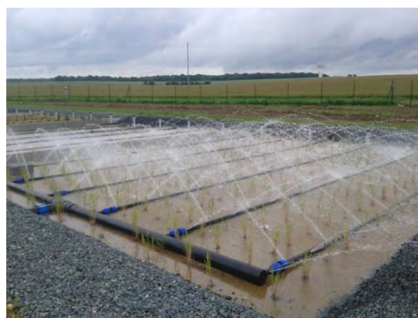
Lits plantés de roseaux de la Grève sur le Mignon (Photo du 2 ème étage des lits)
