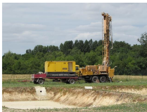
STEP de St Sever de Saintonge : Mise en place de la foreuse pour la réalisation du piézomètre de suivi de la station
