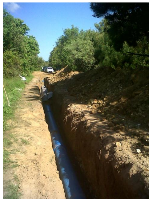
Pose de la nouvelle canalisation sous piste cyclable
