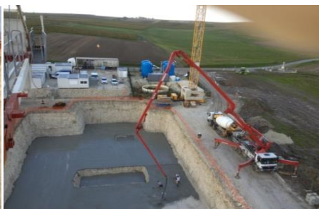
Travaux décembre 2014 : radier
