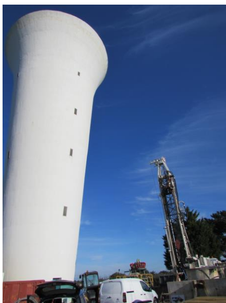
St Georges d'Oléron "Montlabeur F 4 " : Réalisation du forage d'exploitation
