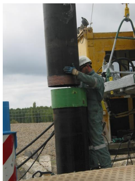
Tubage de la chambre de pompage du forage d'exploitation
