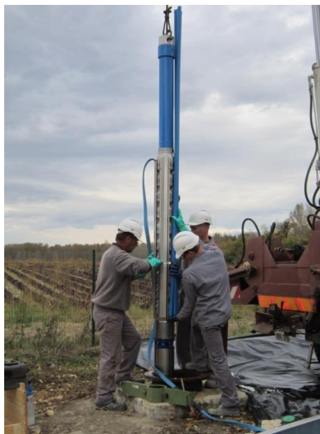
Descente de la pompe dans le forage
