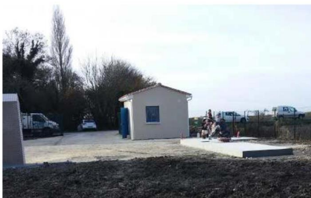
Réalisation de la station de pompage de Ste Lheurine
