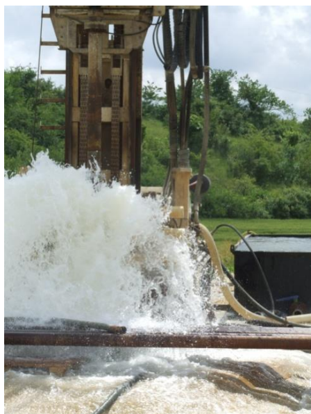
Foration dans le réservoir
