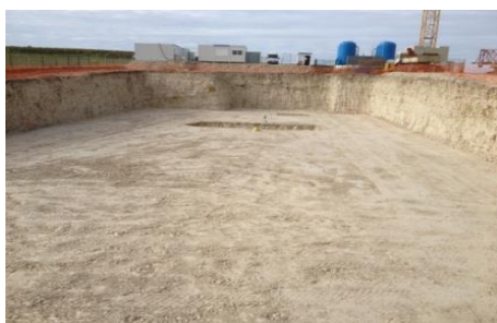
Travaux novembre 2014 : terrassements
