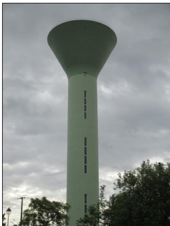
Réhabilitation du réservoir sur Tour de la commune du Gicq
