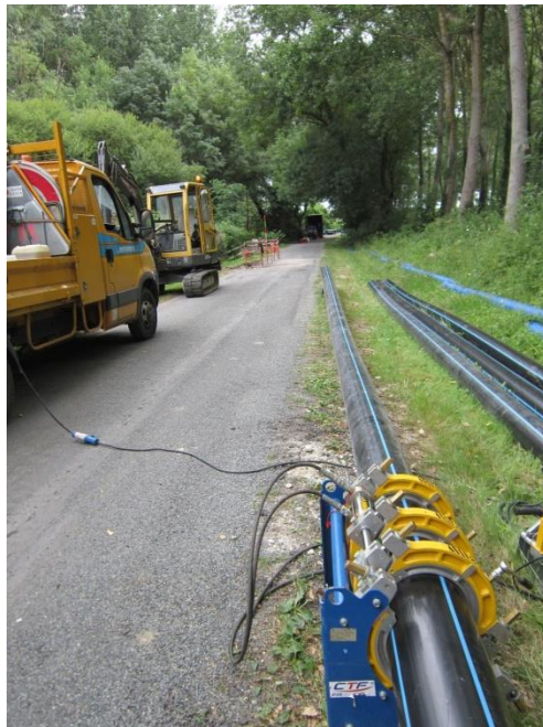
Préparation du forage dirigé
