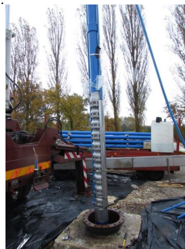
Pose de la pompe du forage de Ste Lheurine « Font de Cluzac »
