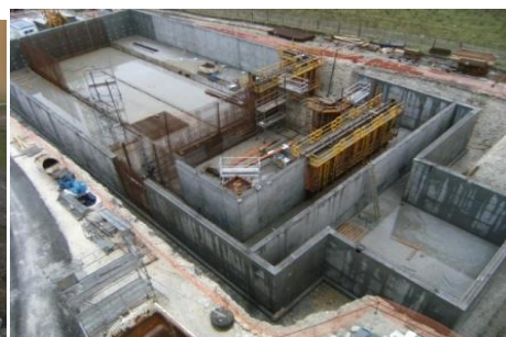
Travaux janvier 2015 : premiers voiles
