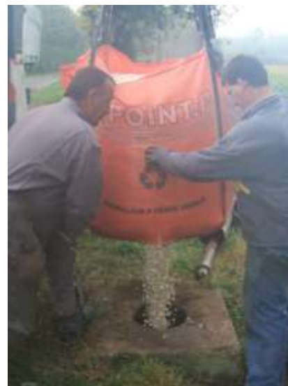
Remblayage avec du gravier 5/15 mm
