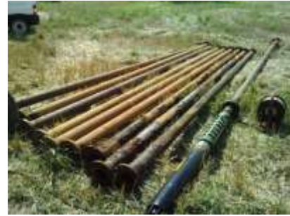
Dépose de pompe immergée
