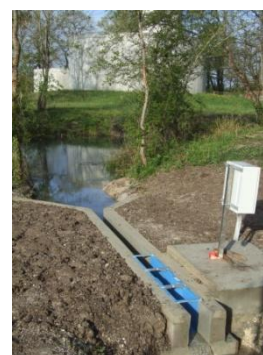
Pose d'un canal venturi
