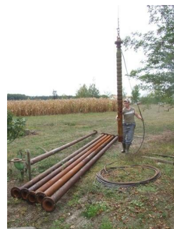
Dépose de pompe immergée
