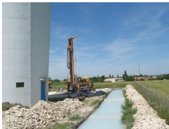
Forage de reconnaissance de Fontaine d'Ozillac "Fief du Breuil" : Foration du réservoir captif du Turonien
