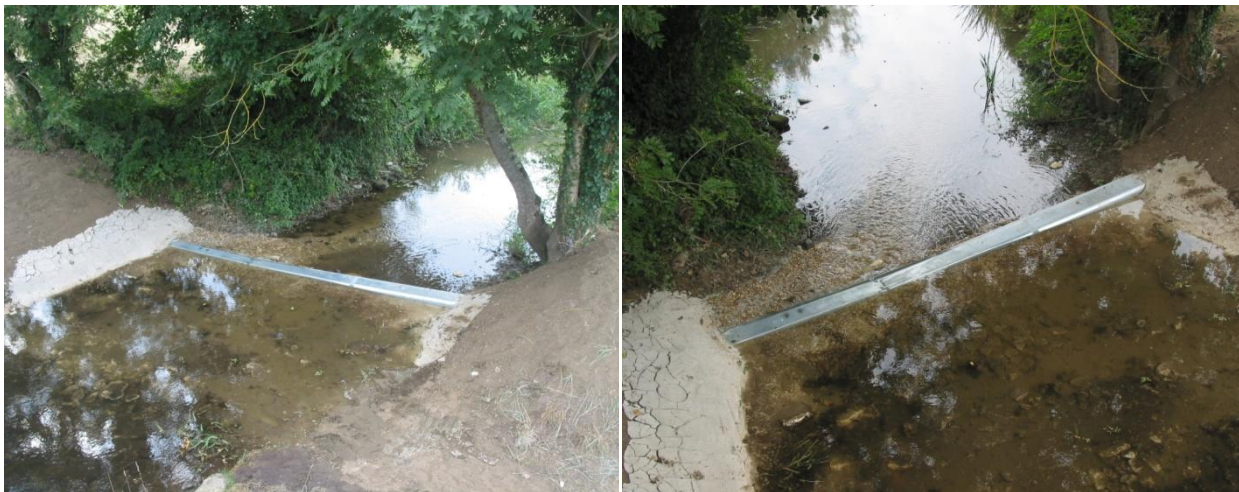
Aménagement du seuil après travaux : passe à poissons est située à gauche du seuil.
