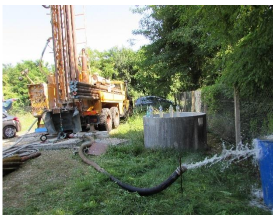
Nettoyage par air lift du forage de Plassay "La Garenne F 2 "
