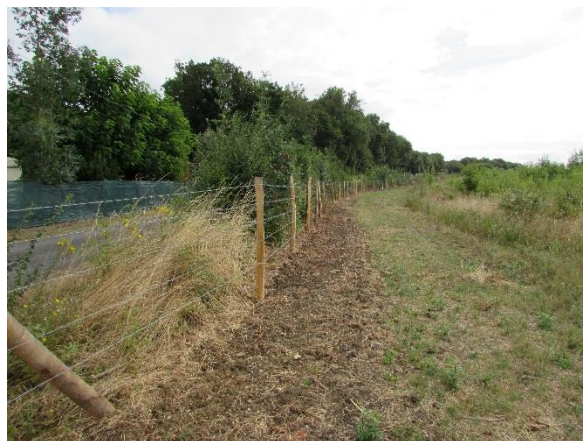
Acquisition de terrains à proximité du captage de St Laurent de la Prée et pose d'une clôture de protection.
