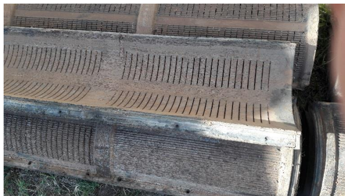
Extraction de crépines en bois du forage de St Georges d'Oléron "Montlabeur F 2 " lors de sa transformation en piézomètre
