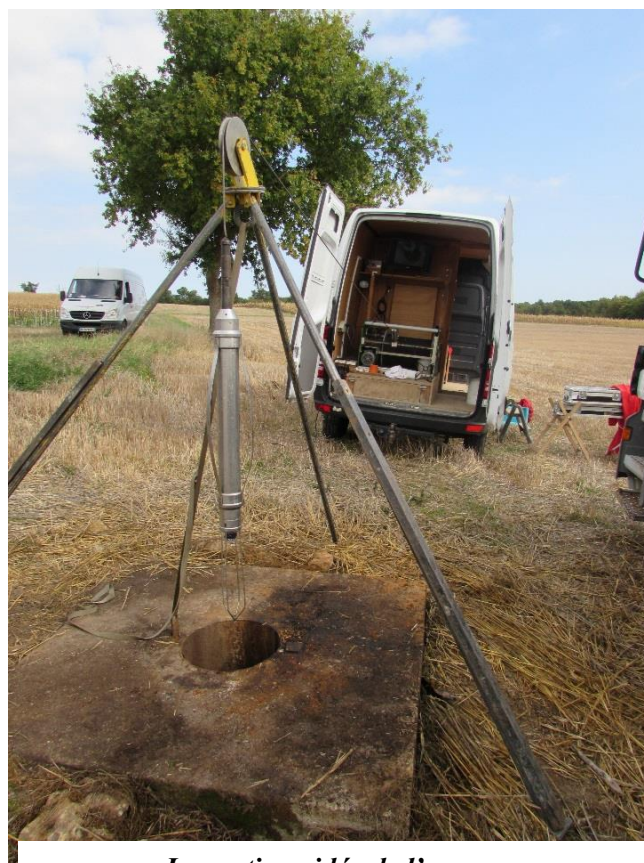
Inspection vidéo de l'ouvrage
