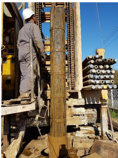
Extraction de crépines en bois du forage de St Georges d'Oléron "Montlabeur F 2 " lors de sa transformation en piézomètre
