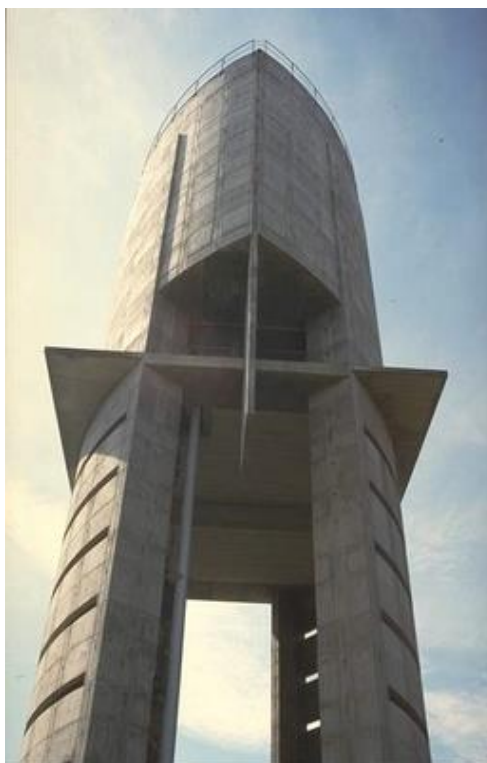
Le réservoir « La Forêt » à BURIE
