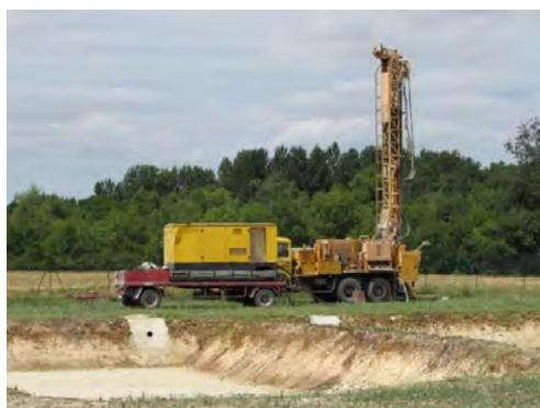
***STEP de St Sever de Saintonge : Mise en place de la foreuse pour la réalisation du piézomètre de suivi de la station***
