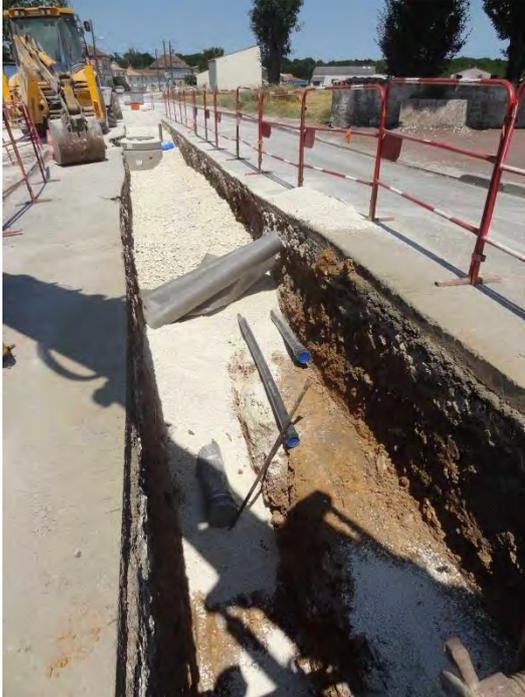
*LES ESSARDS : pose en tranchée commune du réseau d'assainissement, d'une conduite d'adduction d'eau potable et d'une conduite de distribution d'eau potable.*
