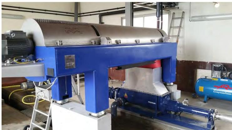
*Centrifugeuse installée dans le local existant*
