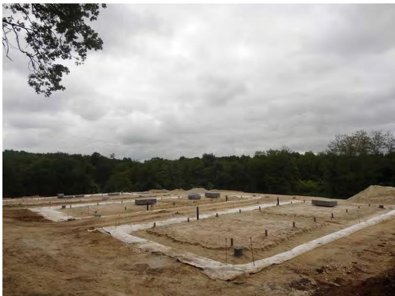
Une station d'épuration de type « filtres plantés de roseaux » a été créée pour recueillir les eaux usées du bourg des **ESSARDS** ainsi que du village des Hermands.
