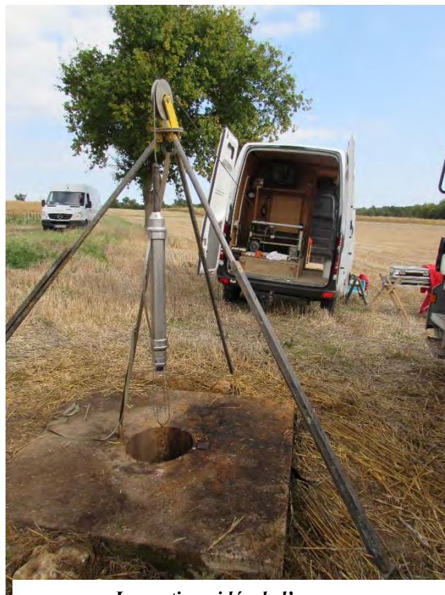
Inspection vidéo de l'ouvrage
