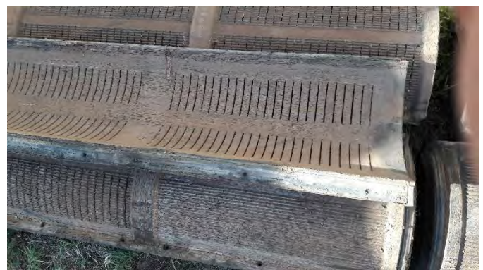
Extraction de crépines en bois du forage de St Georges d'Oléron "Montlabeur F 2 " lors de sa transformation en piézomètre
