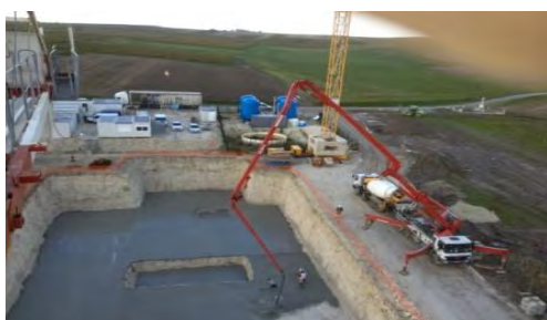
Travaux décembre 2014 : radier
