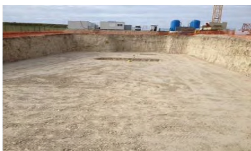
Travaux novembre 2014 : terrassements
