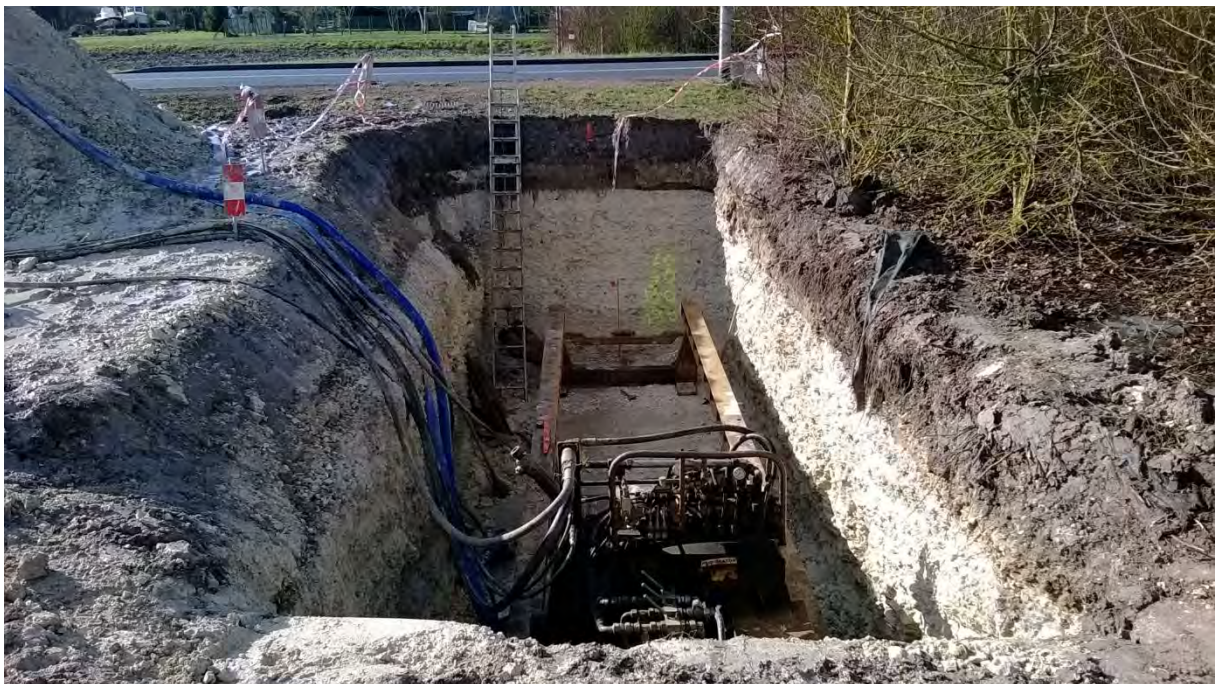
Réalisation de forage sous la départementale
