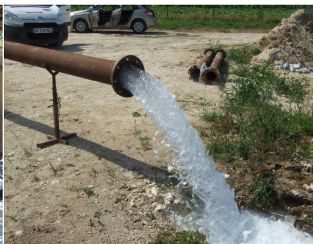
Pompage St Dizant du Gua
