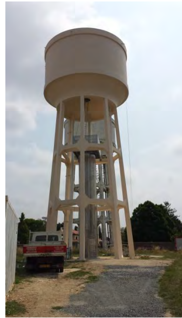
Réservoir de Surgères
