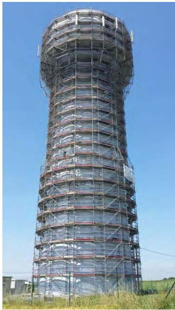
Réservoir de Chenac
