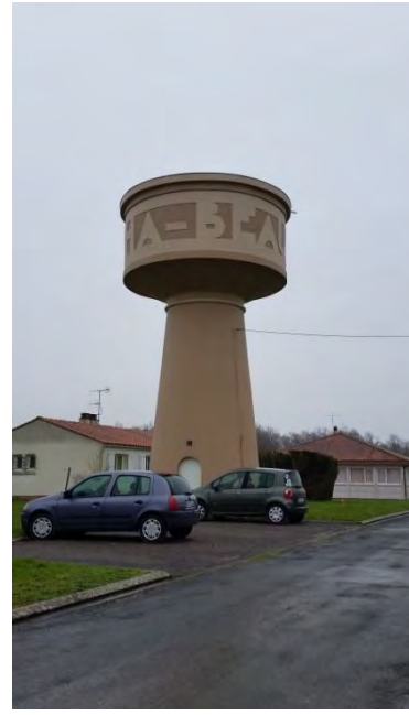
Réservoir de Beauvais s/Matha
