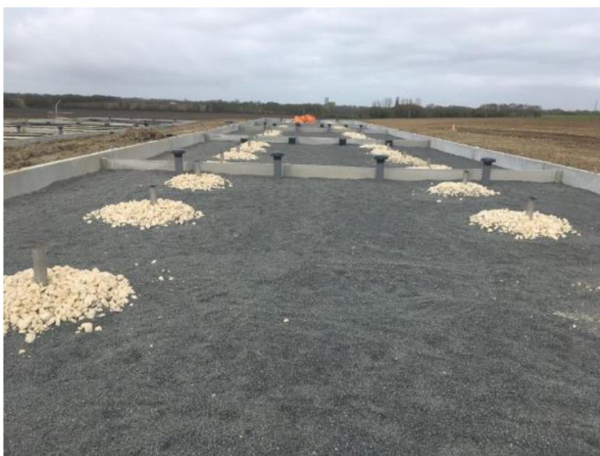
Chantier de l'unité de traitement des eaux usées de Loire Les Marais – 1 er étage avant plantation des roseaux
