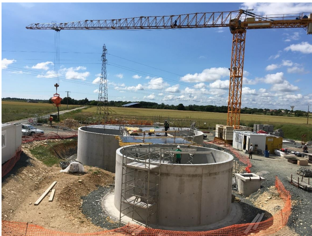
Chantier de la station d'épuration de Charron (boues activées)
