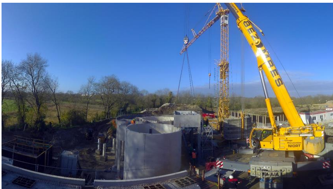
Chantier de modernisation des prétraitements et du poste de relèvement principal de la station d'épuration de Saintes
