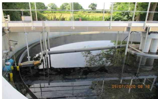
Modernisation de la station d'épuration d'Archiac (nouveau clarificateur)
