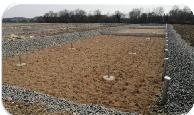
Station d'épuration de Marsais (1000 EH) 1 er étage des lits plantés de roseaux
